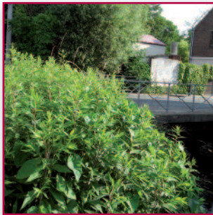
Révision du pont de Nethen
