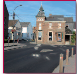
Réfection dégâts d'hiver
